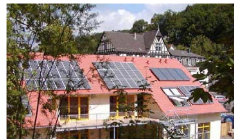
Kindertagesstätte in Marburg: PV und ST auf dem Dach
