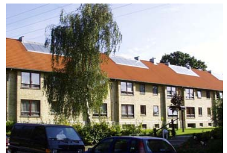
Solarthermie auf einem Mehrfamilien-Bestandsgebäude in Dänemark
